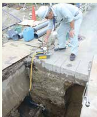
給水装置の水圧を確認
