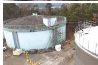
建替予定の緑台高区配水池
