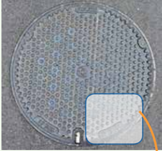
凸凹のついたマンホール
